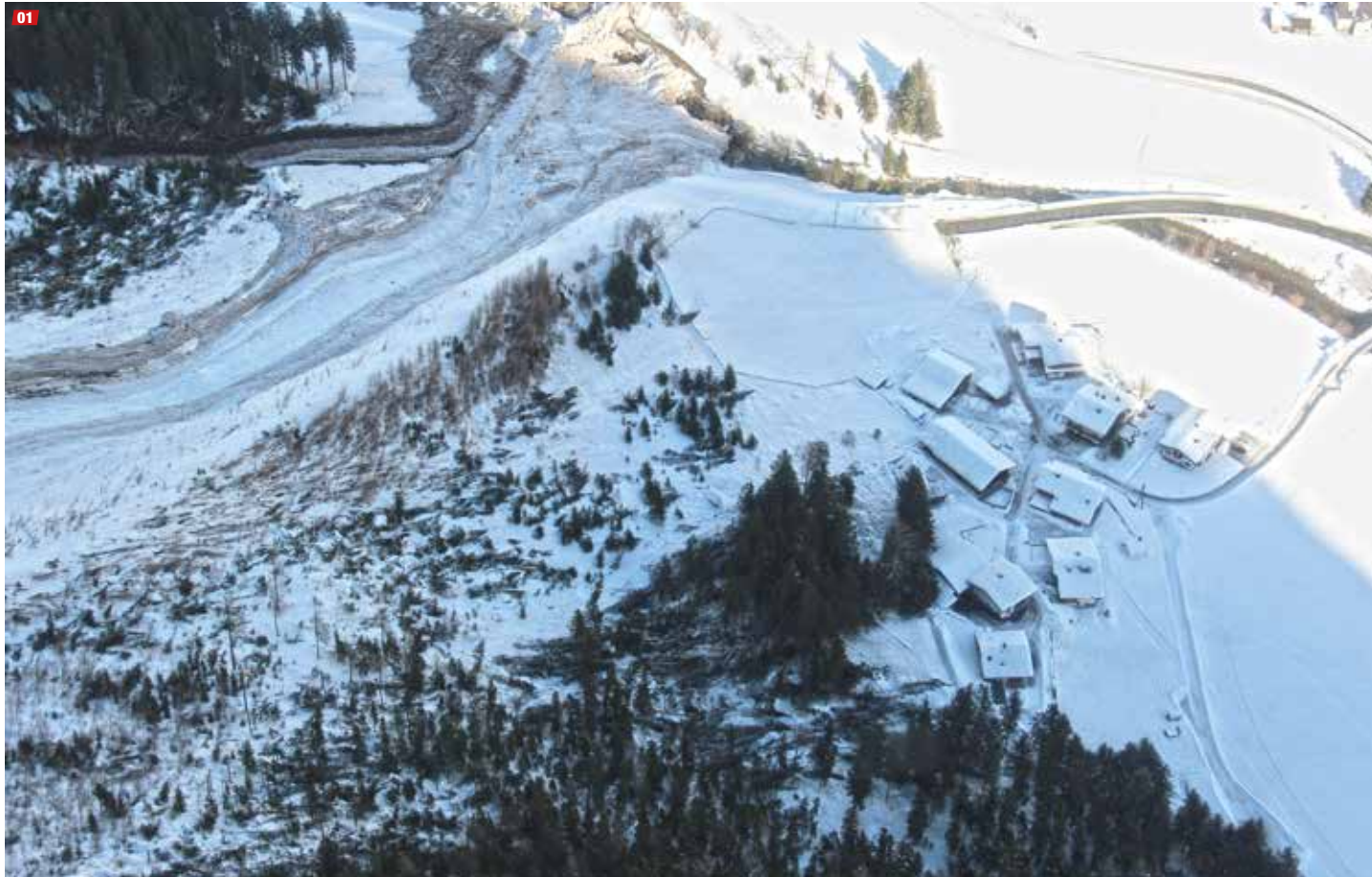
01 Durch die großen Schneemengen des Winters 2017/18 wurden Lawinerverbauungen oftmals „geprüft“. Im Bild die Karbach-Lawine, deren Fließanteil durch die Verbauungen erfolgreich abgeleitet wurde, wodurch keine Schäden an Häusern entstanden. (Foto: LWD Tirol, 24.01.2018) |
