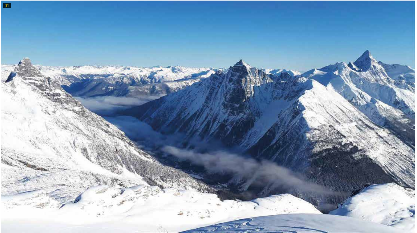
01 Im Bereich des Rogers Passes im Glacier National Park (British Columbia, Kanada) verläuft der Trans-Canada-Highway und die Canadian Pacific Railway zumeist in engen Tälern, die durch steile Berghänge und insgesamt 134 Lawinenstriche flankiert sind. (Foto: Wyssen)
